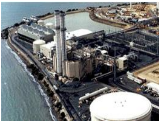
Puerto Rico's EcoEléctrica LNG Terminal.
